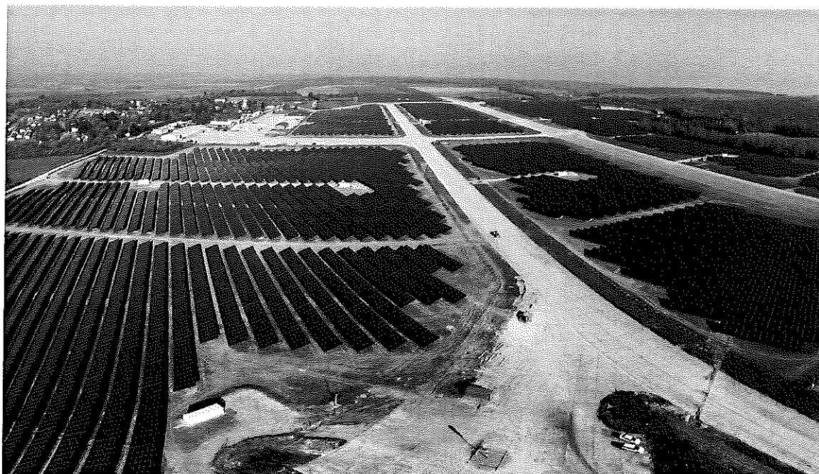
Vue aérienne sur la centrale photovoltaïque et sur les habitations de Marville (55)
